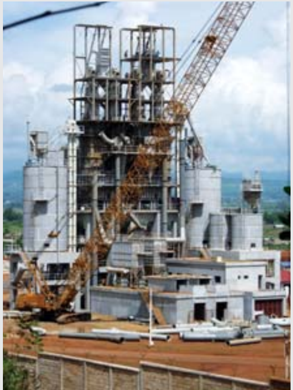
โรงถลุงเหล็กฟินเพชรที่อยู่ระหว่างการก่อสร้าง
